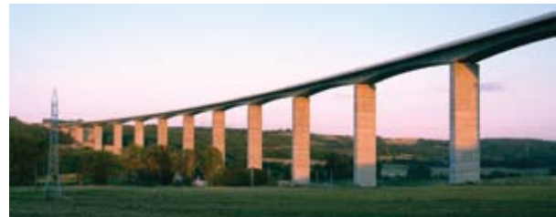
Köröshegyi völgyhíd és az M7-es kapcsolódó szakasza
